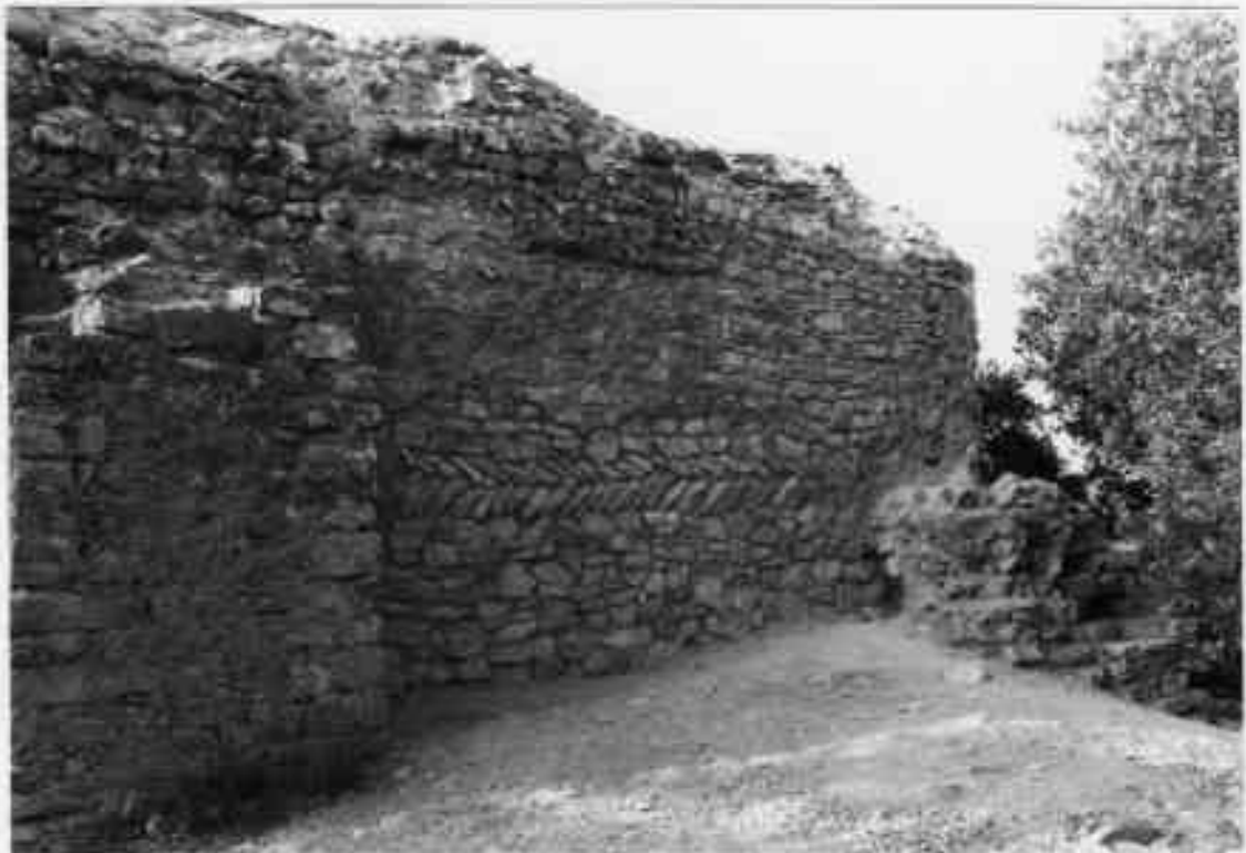
Le mur nord de la chapelle Saint-Pierre redressé jusqu'à la hauteur de la future corniche.
