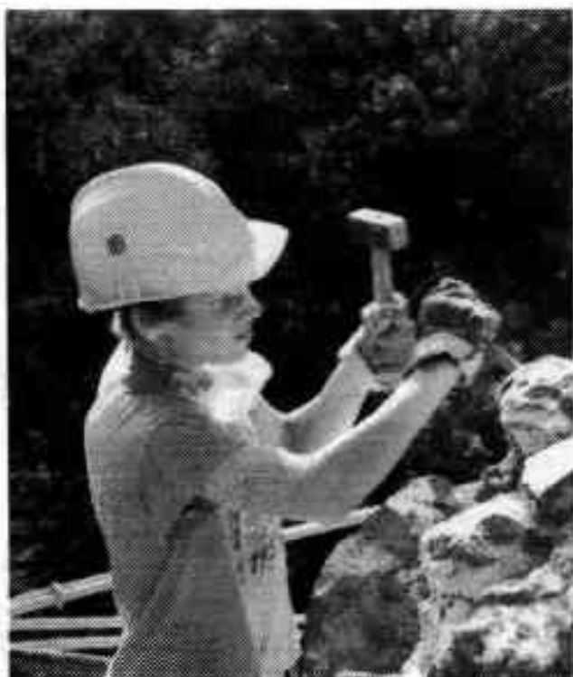
Pendant le chantier 1991
