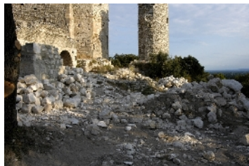
Le chantier : secteur est avant
